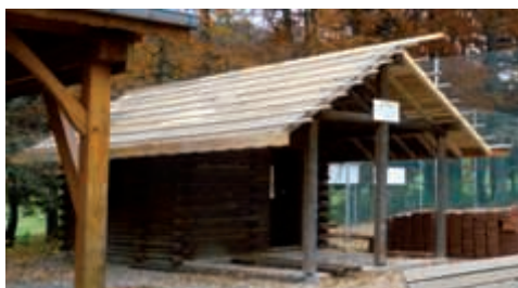
Le chalet à côté du court de tennis pendant sa restauration
