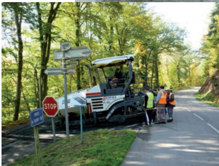
Travaux d'enrobés Chemin de la Chanelle
