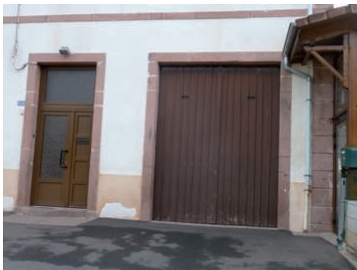
La porte de grange, avant les travaux
